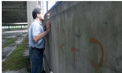
Zbigniew Milczarczyk na budowie magazynu przy ul. Chwaszczyńskiej 133 w Gdyni, rok 2002
