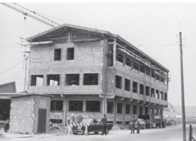
Budowa siedziby Panini
